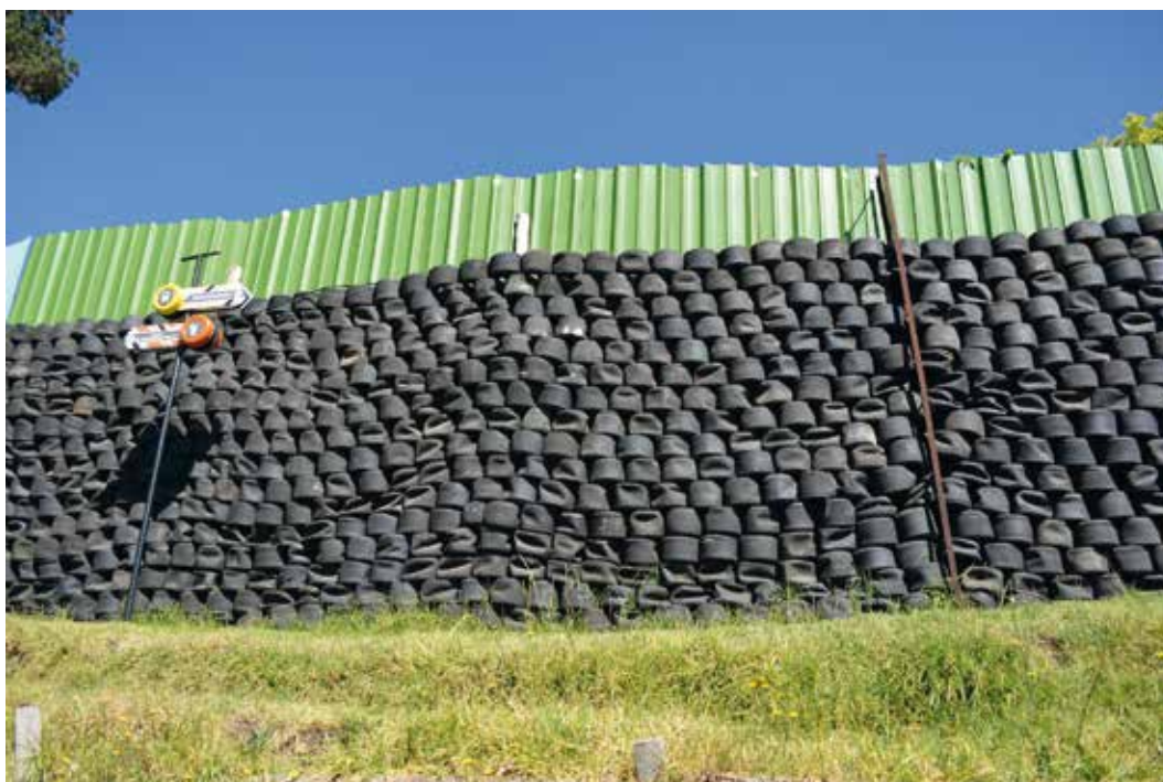
Figura 1. Construcción de barreras artificiales contra el ruido.
